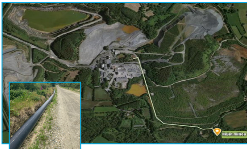
Localisation et photographie de la canalisation de « rejet direct »
