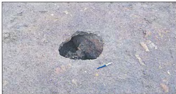
Photo 4 : Erosion régressive au niveau de la plateforme de la verse
